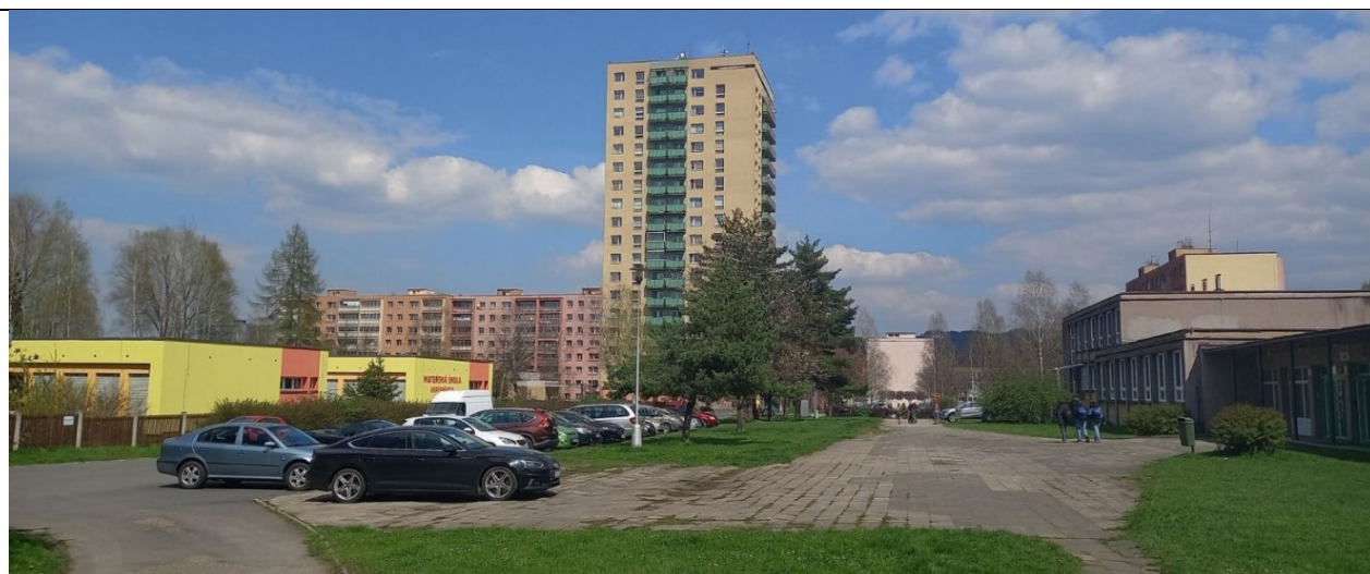
Veřejné prostranství s potenciálem doplnění vzrostlé zeleně a městského mobiliáře mezi budovami MŠ a ZŠ Kopernikova, které mají potenciál k vybudování zelených střech, popř. instalaci FVE
