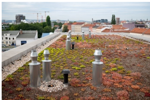
Zelená střecha v Brně na ul. Svatopetrská
