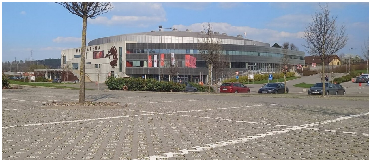
Parkoviště u nového zimního stadionu v Třinci, parkovací místa s propustným povrchem.
