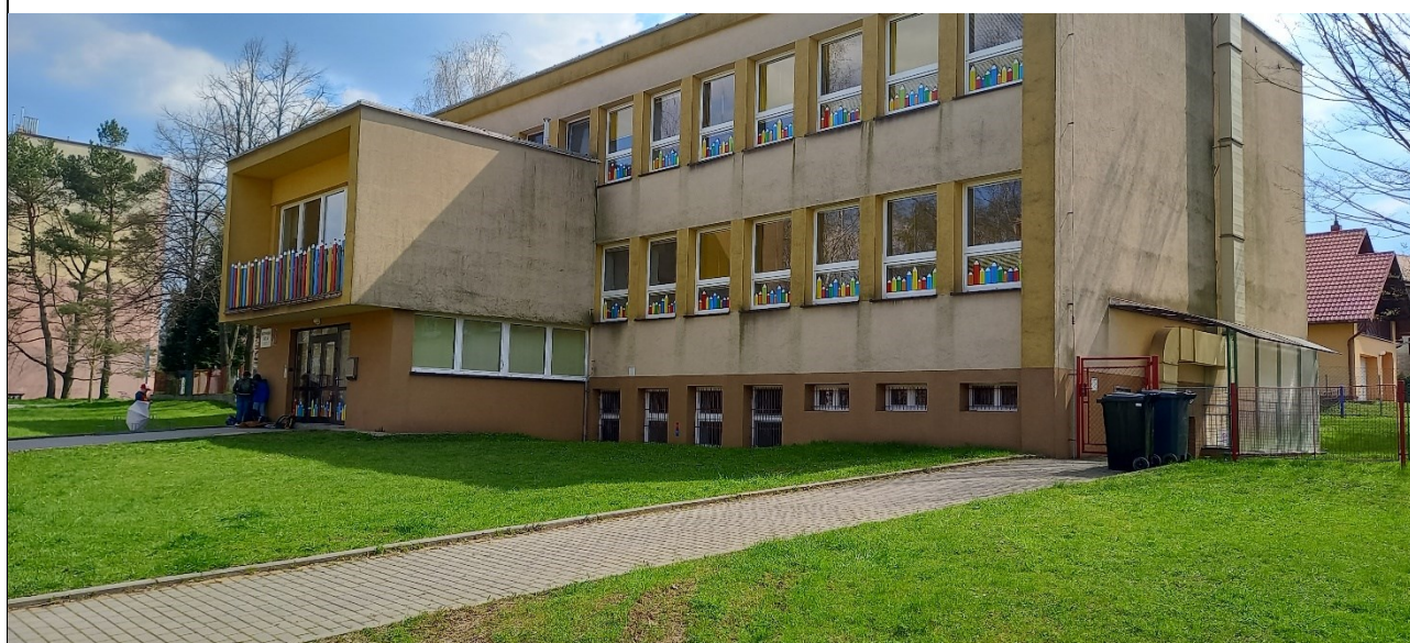
Prostranství s potenciálem doplnění vzrostlé zeleně u budovy MŠ Slezská, zvážit možnost vybudování zelené střechy, popř. instalaci FVE
