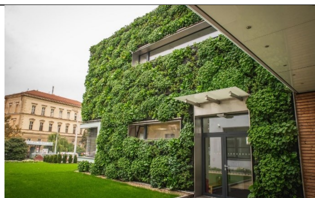
Využití vertikální zeleně přispívá ke zlepšení mikroklimatu i k ochraně vlastní budovy (Brno, Kancelář Veřejného ochránce práv)
