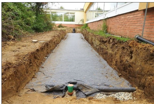
Parkoviště u nového zimního stadionu v Třinci, parkovací místa s propustným povrchem.
