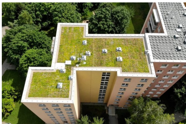
Zelená střecha bytového domu v Brně - Bohunicích
